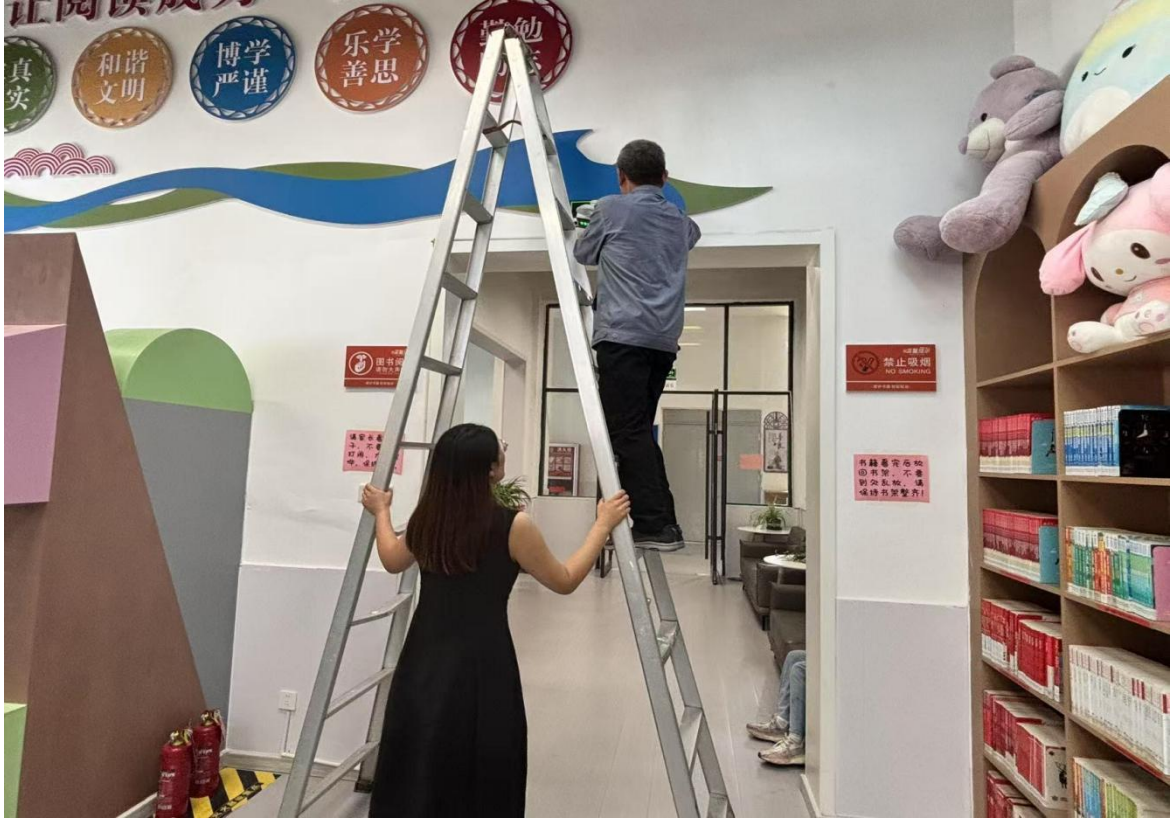
2025.1.1--12.31 消防设施设备维修
